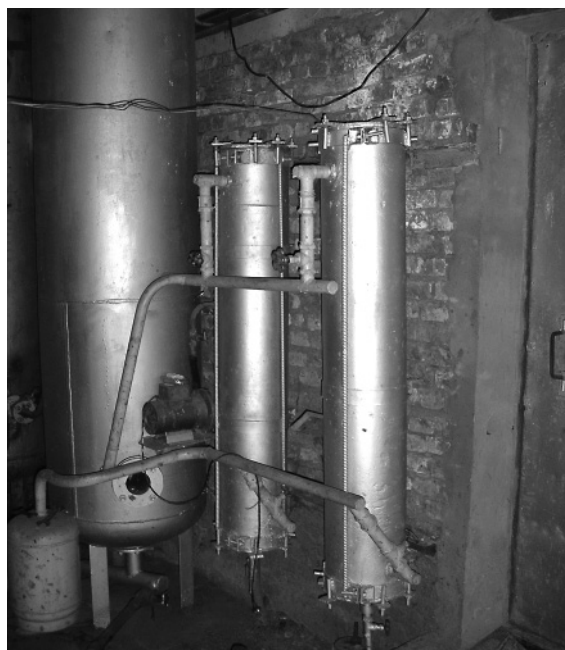
Рис.38. Сероводородный фильтр и абсорбер для отделения углекислоты в с. Петровка.
