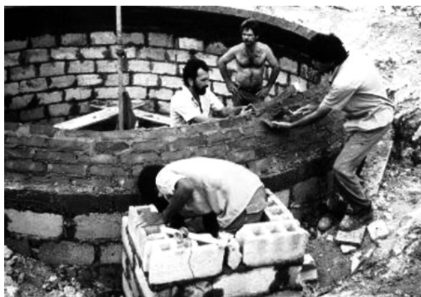
Рис.16. Сооружение кирпичного реактора на Кубе.
