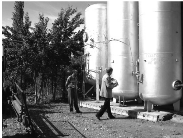
Рис.23а. Стальные газгольдеры среднего давления в с. Петровка. Фото: Веденев А.Г., ОФ «Флюид»
