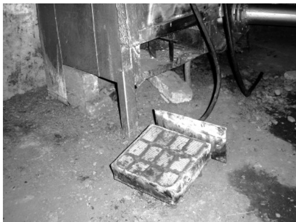
Рис.27. Водонагревательный котел системы обогрева реактора в с. Петровка. Фото: Веденев А.Г., ОФ «Флюид»
