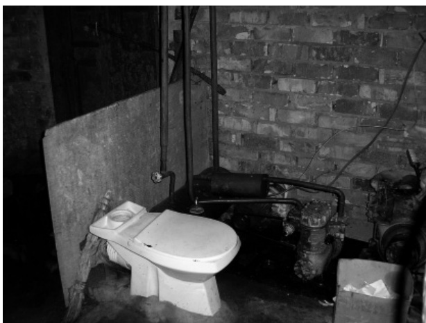
Рис.9. Совмещенная переработка фекалий в биогазовой установке с. Беловодское. Фото: Веденев А.Г., ОФ «Флюид»
