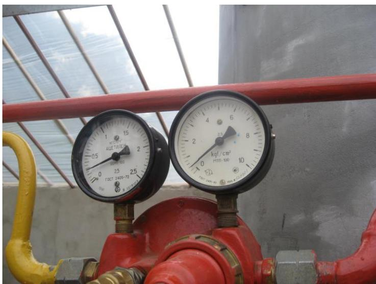
**Рис.53. Регулятор давления газа**
