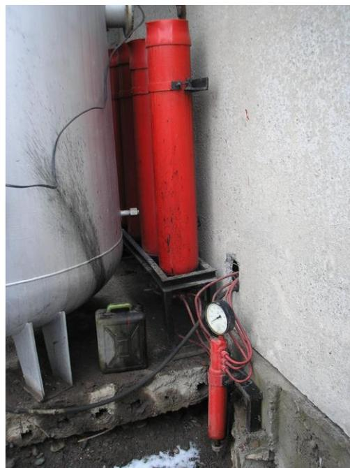
**Рис.42. Стальные газгольдеры высокого давления в с. Петровка**
