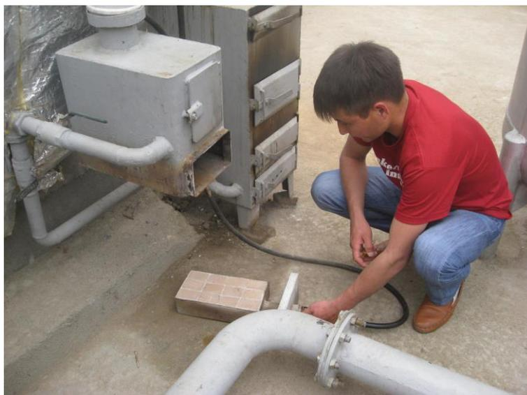
**Рис.47. Водонагревательный котел системы обогрева реактора с керамическими излучателями**
