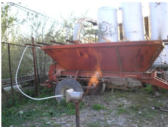
**Рис.57. Факельная горелка для сжигания излишков биогаза в с. Петровка**
