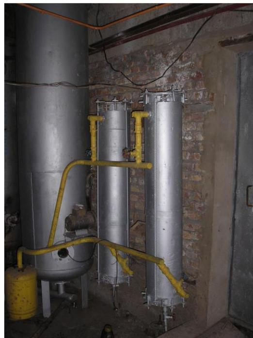
**Рис.55. Сероводородный фильтр и абсорбер для отделения углекислоты в с. Петровка**
