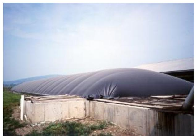
**Рис.20. Установка канального типа**
