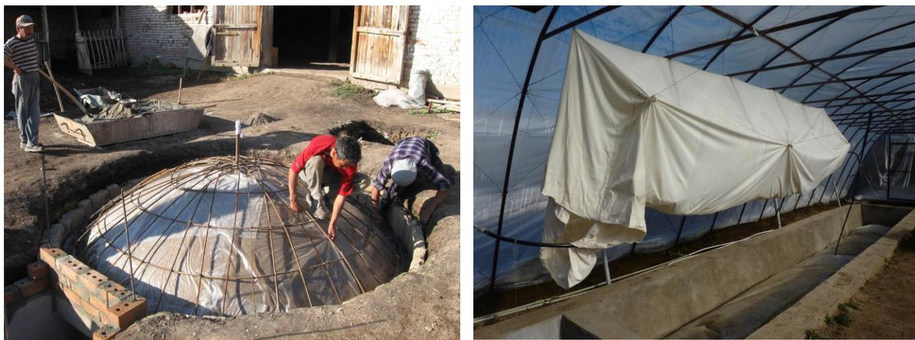
**Рис. 37. Купольная биогазовая установка с кирпичным реактором(слева) и канальная установка (справа) на стадии строительства в с. Саруу, Иссык-Кульская область КР (проект JICA).**
